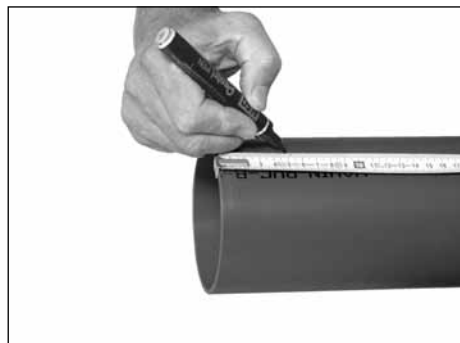
Obr. 30 – Označení požadované zásuvné délky
