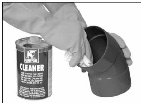
Obr. 31, 32 – Ošetření stykových ploch PVC čistícím přípravkem
