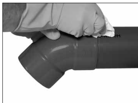
Obr. 36 – Odstranění přebytečného množství lepidla
