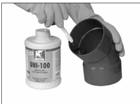
Obr. 33, 34 – Aplikace lepidla na lepené plochy
