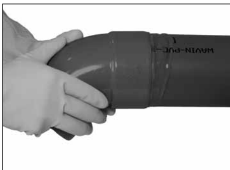
Obr. 35 – Nasunutí tvarovky na konec trubky
