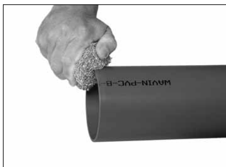
Obr. 28, 29 – Odstranění otřepů a nerovností řezu
