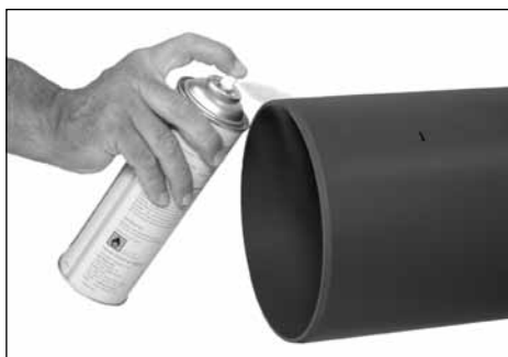
Obr. 42, 43 – Mazání styčných ploch mezi trubkou a kompenzačním hrdlem
