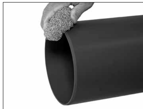
Obr. 39, 40 – Zkosení hrany trubky
